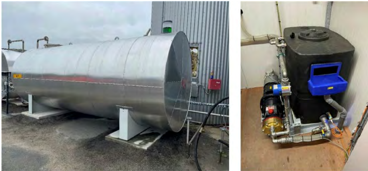
Figuur 8. Tank met additief (links) en Menging water en additief (rechts)
