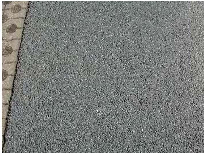
Figuur 10. Oppervlaktetextuur SMA-NL 11B LynPave na 6,5 jaar
