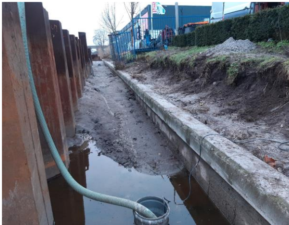
Figuur 2.1: Overzichtsfoto damwand.
