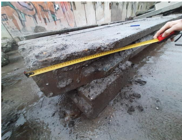
Figuur 5.7: detail damplank
