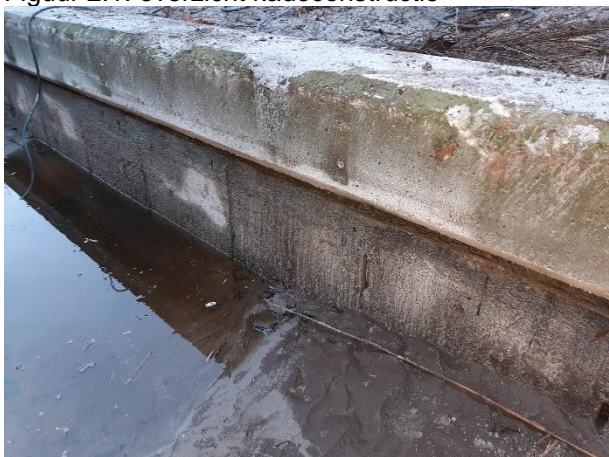
Figuur 2.3: detail deksloof en damplanken
