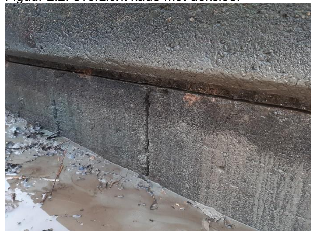
Figuur 2.4: detail ingezaagd damplanken en deksloof
