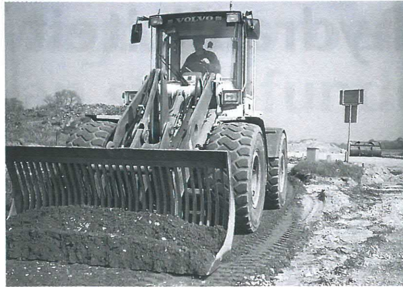
SPREIDING VAN MENGGRANULAAT IN DE WEG
