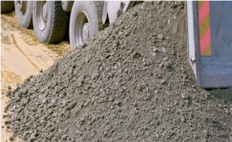
Immobilisaat voor verwerking (foto site immobilisatie)
