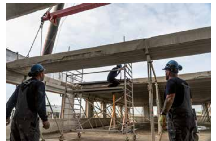
Demontage van de kanaalplaatvloeren in het Prinsenhofgebouw.
