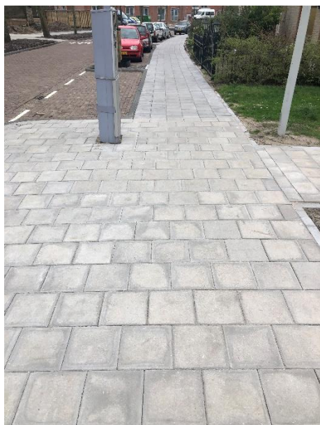
Figuur 16. Pilot Gemeente Amsterdam: bestrating van geopolymer betontegels met cement gebonden toplaag.
