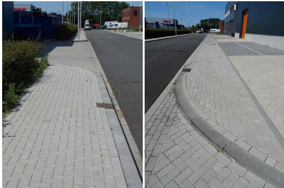
Figuur 3. Pilot Gemeente Alphen aan den Rijn: beeld van het werk met geopolymer beton straatstenen met een cement gebonden toplaag na anderhalf jaar.
