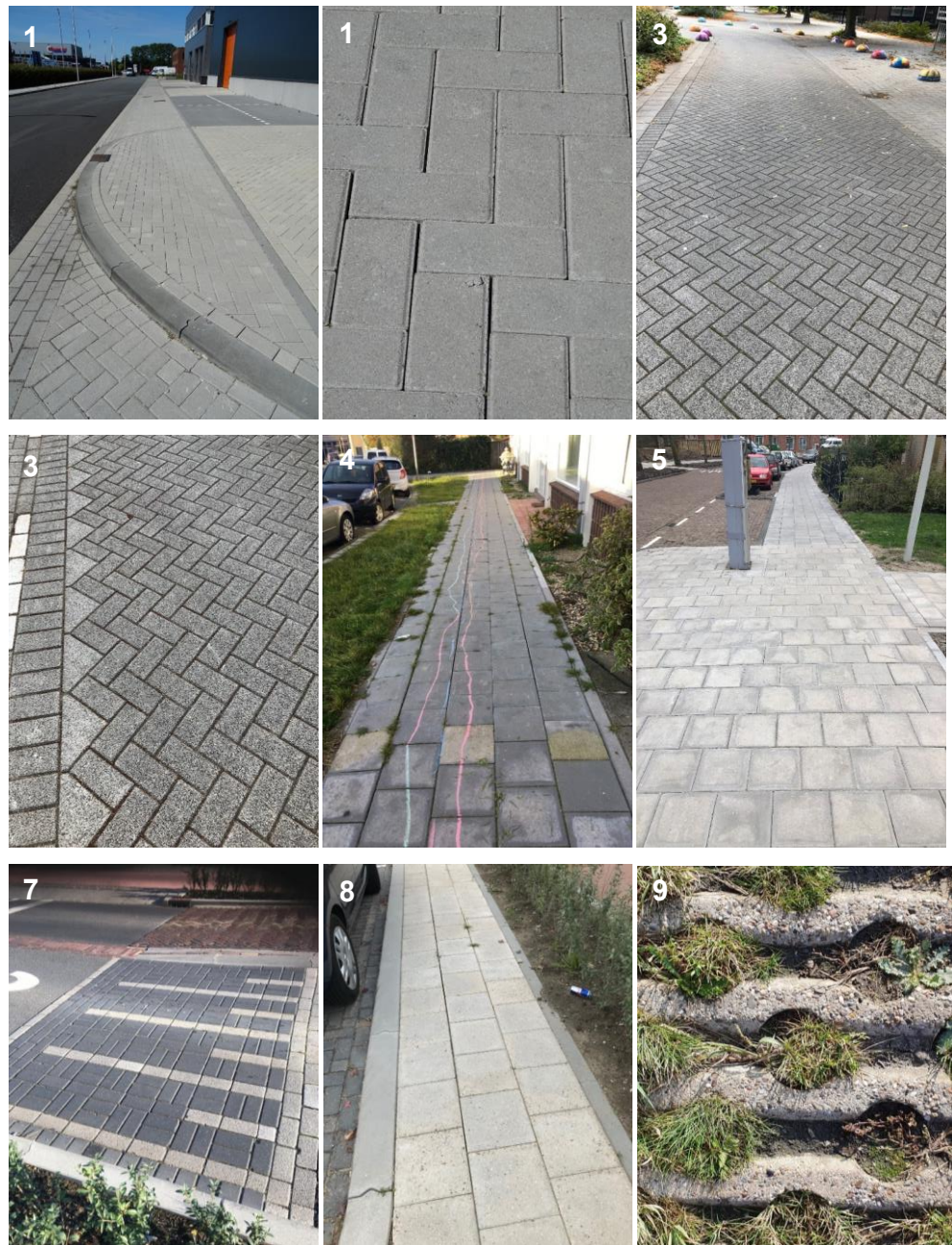
Figuur 35. Proeftuin Geopolymeren: impressie van de pilots met geopolymeer betonwaren. De nummers corresponderen met het pilotnummer. 1 – Gemeente Alphen aan den Rijn, na 1,5 jaar. 3 – Gemeente Rotterdam, na 1 jaar, 4 – Gemeente Amersfoort, na een half jaar, 5 – Gemeente Amsterdam, na oplevering, 7 – Gemeente Nijmegen, na een half jaar, 8 – Gemeente Dordrecht, na 1 jaar, 9 – Provincie Groningen, na 1 jaar.
