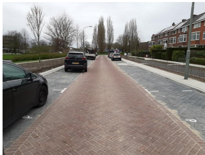
Figuur 27. Pilot Gemeente Dordrecht: overzicht van het werk; de parkeervakken en trottoirs zijn uitgevoerd in betonwaren, de rijbaan in gebakken klinkers.
