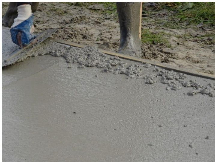
Figuur 22. Pilot Gemeente Leeuwarden: afwerken betonoppervlak circa een halve dag na het storten.
