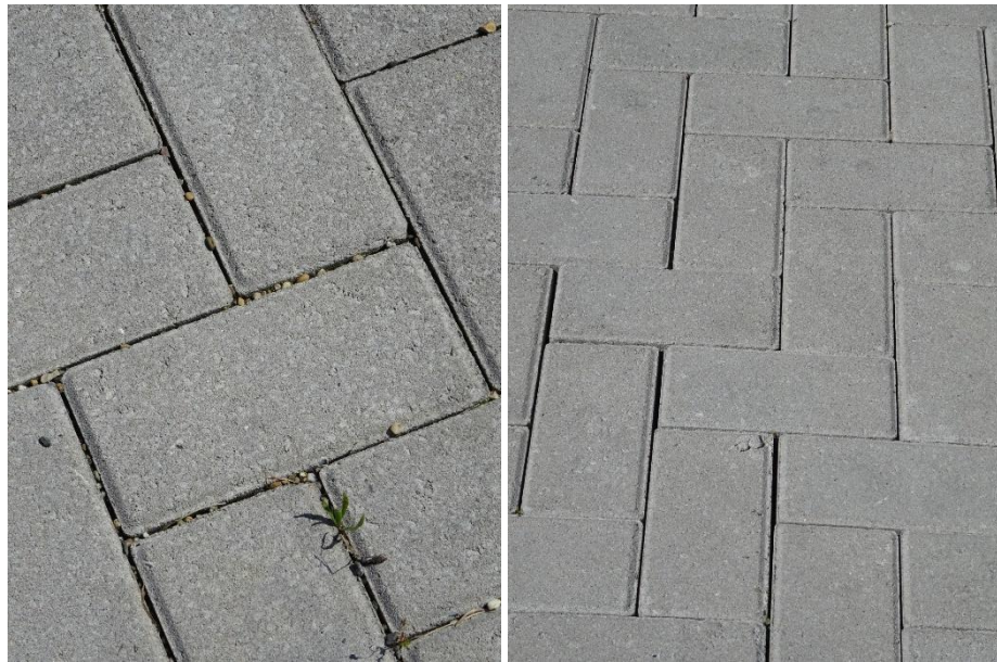
Figuur 5. Pilot Gemeente Alphen aan den Rijn: geopolymeer betonstraatstenen met cement gebonden toplaag na anderhalf jaar.
