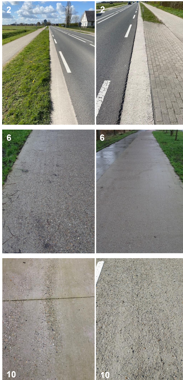
Figuur 37. Proeftuin Geopolymereen: impressie van de pilots met in het werk gestort geopolymeer beton. De nummers corresponderen met het pilotnummer, 2 – Provincie Gelderland, na 22 maanden (na de vorst van februari 2021). 6 – Gemeente Leeuwarden, na 13 maanden (voor de genoemde vorstperiode); links de eerst gestorte moot, rechts de laatst gestorte. 10 – Provincie Overijssel, na 14 maanden (na de vorstperiode).
