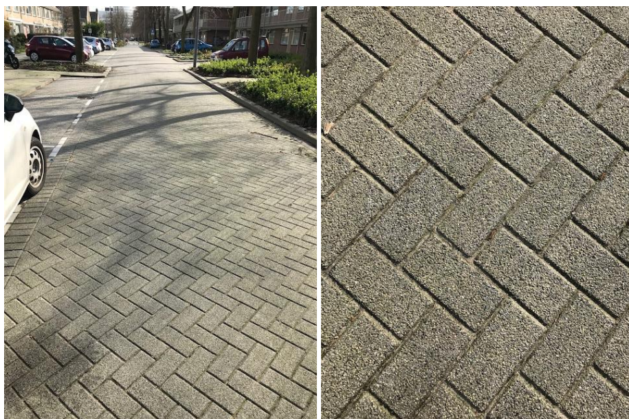
Figuur 11. Pilot Gemeente Rotterdam: geopolymeer betonstraatstenen met cement gebonden toplaag in Goudkruid na 6 maanden.
