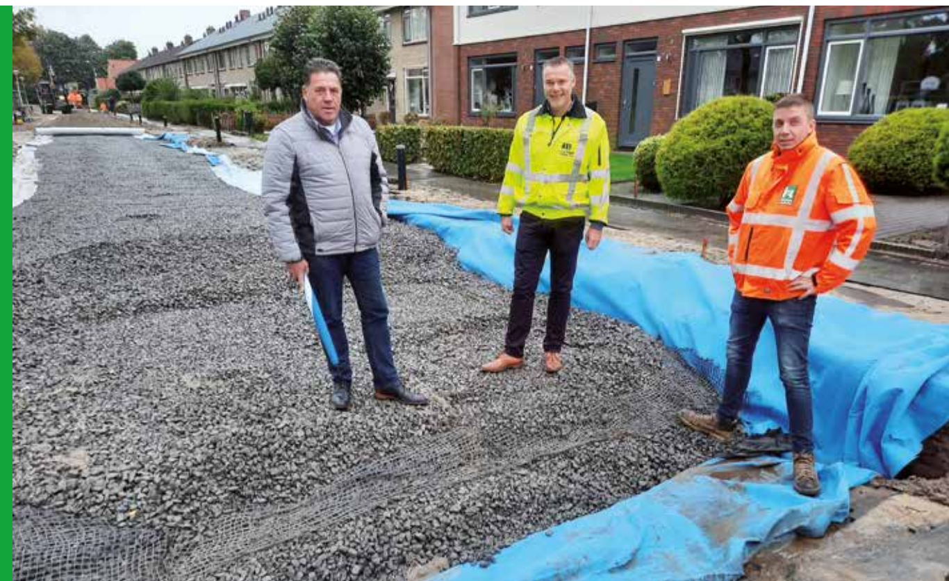
Op de foto van links naar rechts: Roel Koster (wethouder Gemeente Twenterand), Berry Mullink (hoofd verkoop vd Bosch Beton) en Rick Jansen (uitvoerder Reko Raalte). De blauwe folie is GeoClean aquatextiel die voorkomt dat minerale oliën in de bodem of het grondwater terecht komen. (Foto: Hugo Wiggers)
