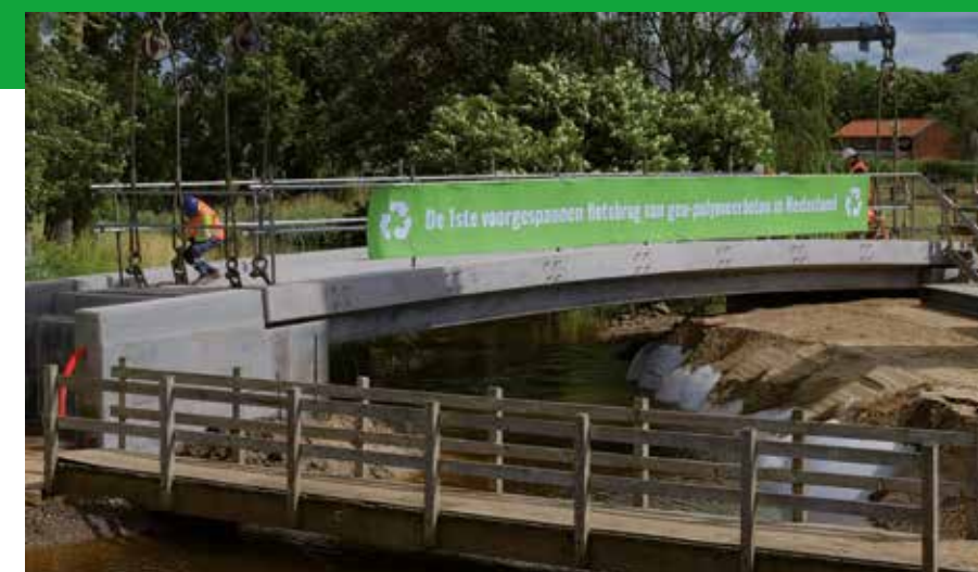
Duurzame fietsbrug van voorgespannen geopolymeerbeton. Info: grenscorridor69.nl
