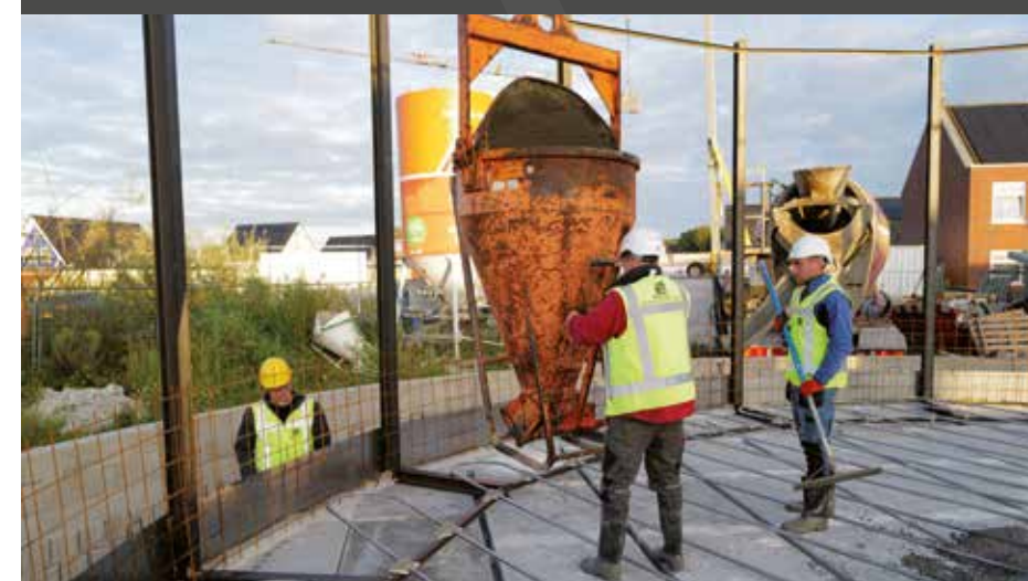
Stort van extra zware beton voor CESAR-warmteaccu in extreem duurzaam woningbouwproject te Boekel.
