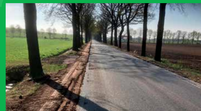
De Koeveringsdijk in de gemeente Meierijstad. Nieuw wegdek, voor een deel voorzien van Partiële Recycling (PR) in Steen Mastiek Asphalt (SMA).
