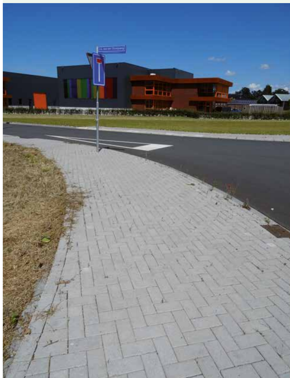
Pilot Gemeente Koudekerk aan den Rijn: Geopolymeer betonbestrating na anderhalf jaar.
