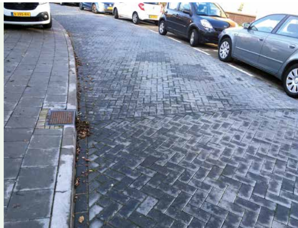
Pilot Gemeente Amersfoort: Geopolymeer betonbestrating na een jaar.
