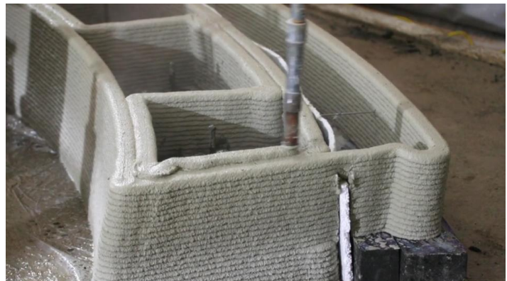
Afbeelding 7: onderzijde geprinte wanden met uitstekende stekeinden, buitenste schil op foamglas en een isolatieplaat (bron: Mediavisie)
