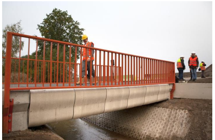
Afbeelding 24: fietsbrug (wereldprimeur) in Gemert (BAM).
