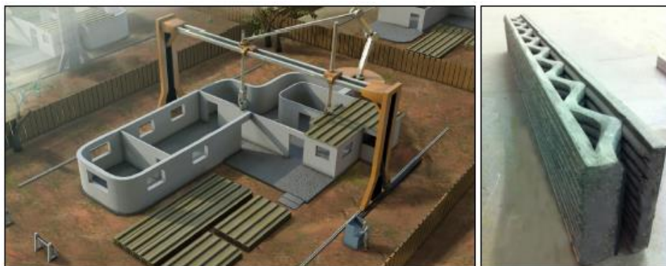
Afbeelding 2: contour crafting door Universiteit van Zuid-Californië (2014).
