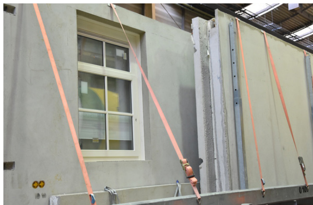
Prefab wanden met vezelversterkt beton
