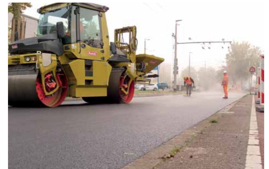
De onderlaag van het wegdek behoefde geen extra bewerking.
