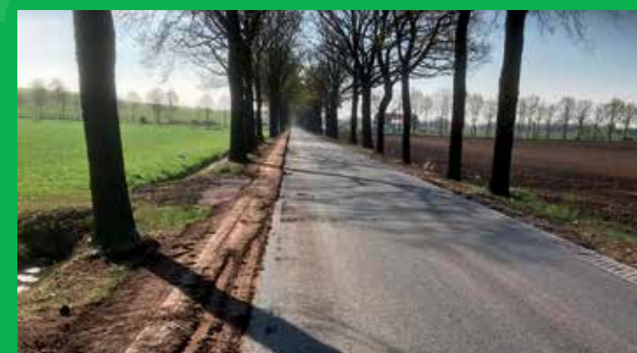
De Koeversingsdijk in de gemeente Meierijstad. Nieuw wegdek, voor een deel voorzien van Partiële Recycling (PR) in Steen Mastiek Asfalt (SMA).
