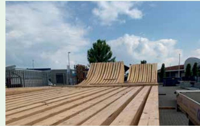
De bewerkte spanten liggen klaar om te worden opgenomen in het nieuwe bedrijfspand van ColPro in Almelo.
