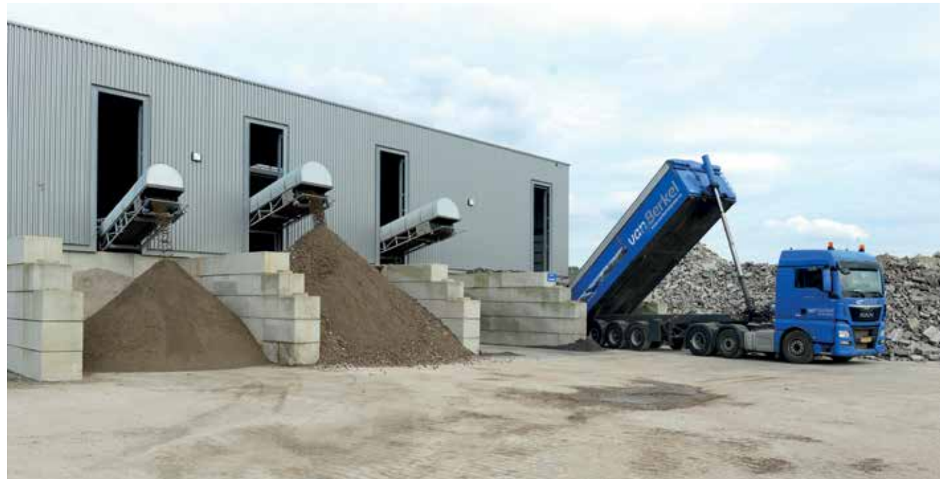
Granulaatcentrale bij Van Berkel Bouwstoffen & Transport in Eindhoven. Steenachtige reststoffen als puin, beton en asfalt, worden hier verwerkt tot een breed aanbod van bouwstoffen voor gebruik in infrastructuur en waterbouw.
