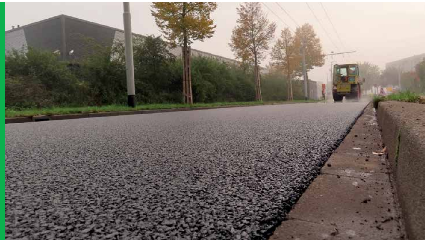
Het aanbrengen van de nieuwe asfaltdeklaag in Arnhem. Het hergebruik van freesasfalt is in ons land nog niet eerder op deze manier gebeurd.
