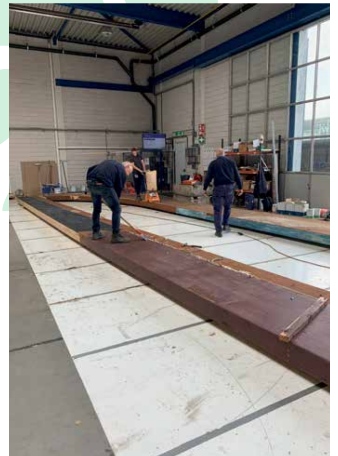
De spanten uit Harderwijk worden gereedgemaakt voor hergebruik in Almelo.
