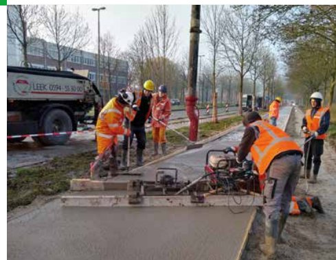
Uitvoering geopolymeerbeton in een nieuw fietspad langs de Kanaalweg.
