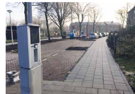
Geopolymeerstenen Rode Kruisstraat in Amsterdam.
