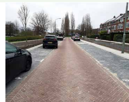
Herinrichting Hugo de Grootlaan in Dordrecht. Met toepassing van geopolymeer betonmateriaal in diverse vormen.
