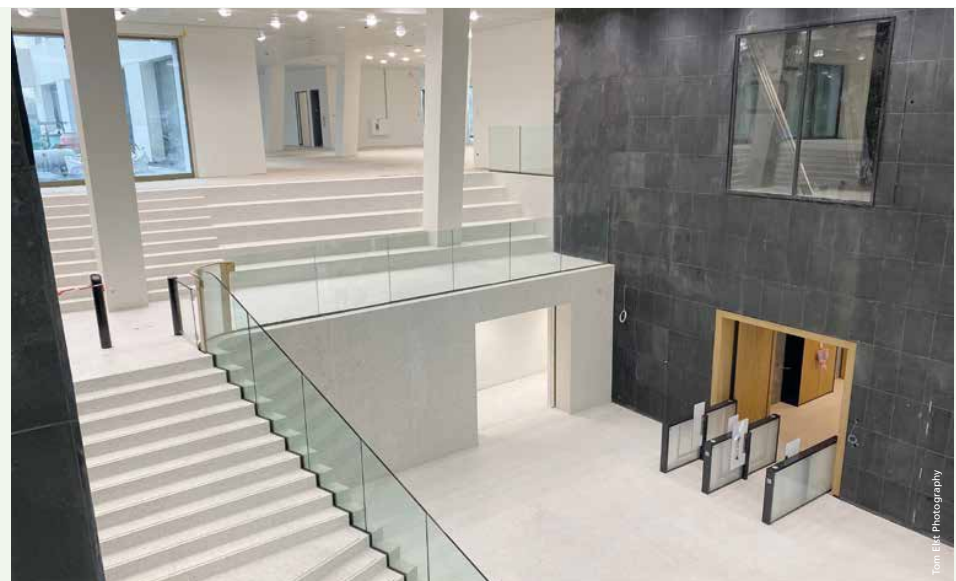
Hourglass Amsterdam. Cees Dam Architecten. Prefab entree en trap in terrazzo. Jaar 2019-2020
