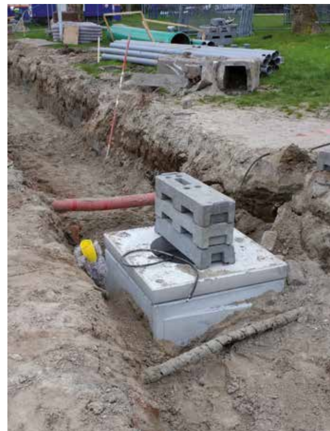
Werkzaamheden circulaire reconstructie Elbasterwei in Holwerd.
