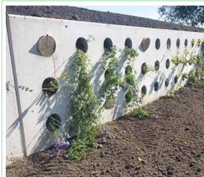
Bio-keerwand, recent door Bosch Beton gelanceerd. Deze circulaire wand is in samenwerking met MVO Nederland, een hovenier en een advies- en ingenieursbureau speciaal ontwikkeld om de biodiversiteit te bevorderen.
