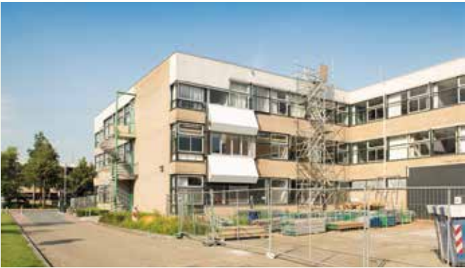
Gevelrenovatie in uitvoering.
