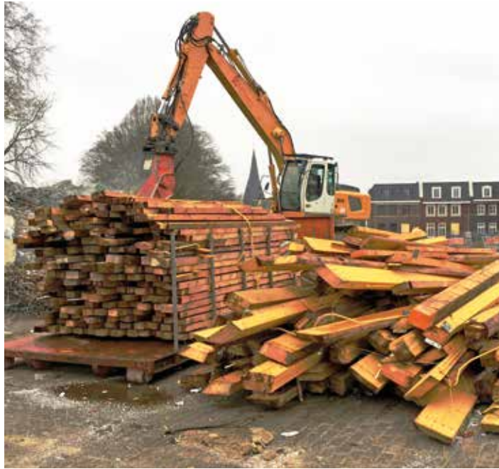
Oogsten van kniespanen, hergebruikt voor de dakopbouw van Boschgaard.
