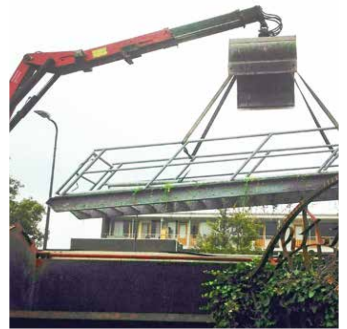
Brandtrap wordt geoogst.
