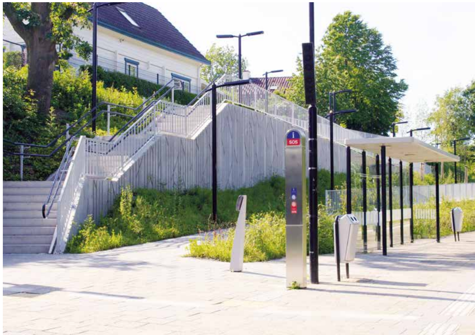
Keerwanden van Bosch Beton op het nieuwe spoorwegstation Chevremont-Kerkrade.
