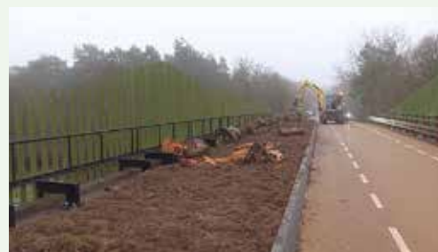
Biobased vangrail voor het Zoomlandviaduct over rijksweg A58 in Bergen op Zoom, uitgevoerd door Dura Vermeer.
