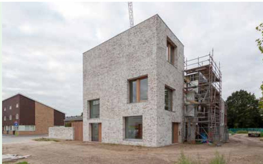
Koopvaardersplantsoen Amsterdam. Hergebruikte stenen met een speciaal ontwikkelde voeglaag.
