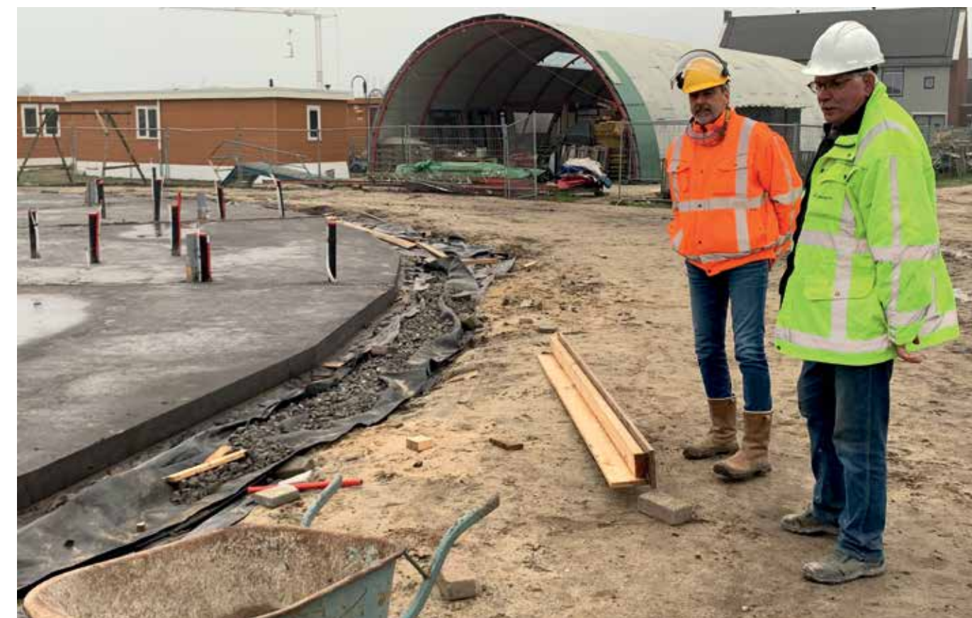
De beganegrondvloeren in Boekel worden gestort. Direct glad en vlak.
