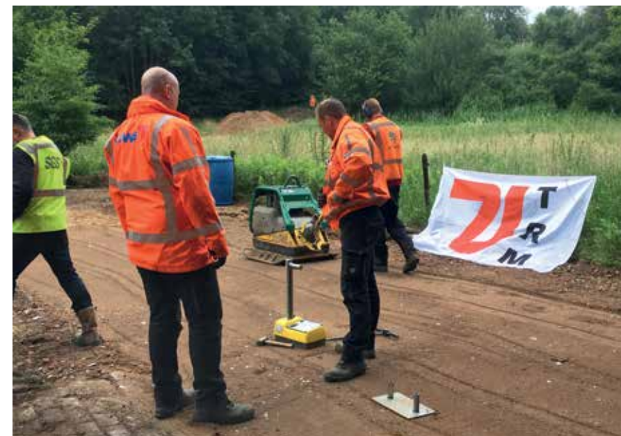
Onder een aanvoerweg van de voormalige stortlocatie 't Rikkerink in Ambt-Delden is proefgedraaid met een fundatiemix uit bodemas en menggranulaat. De mix is ontwikkeld door energiecentrale Twence en puinrecyclingbedrijf Twee "R" Recycling Groep.
