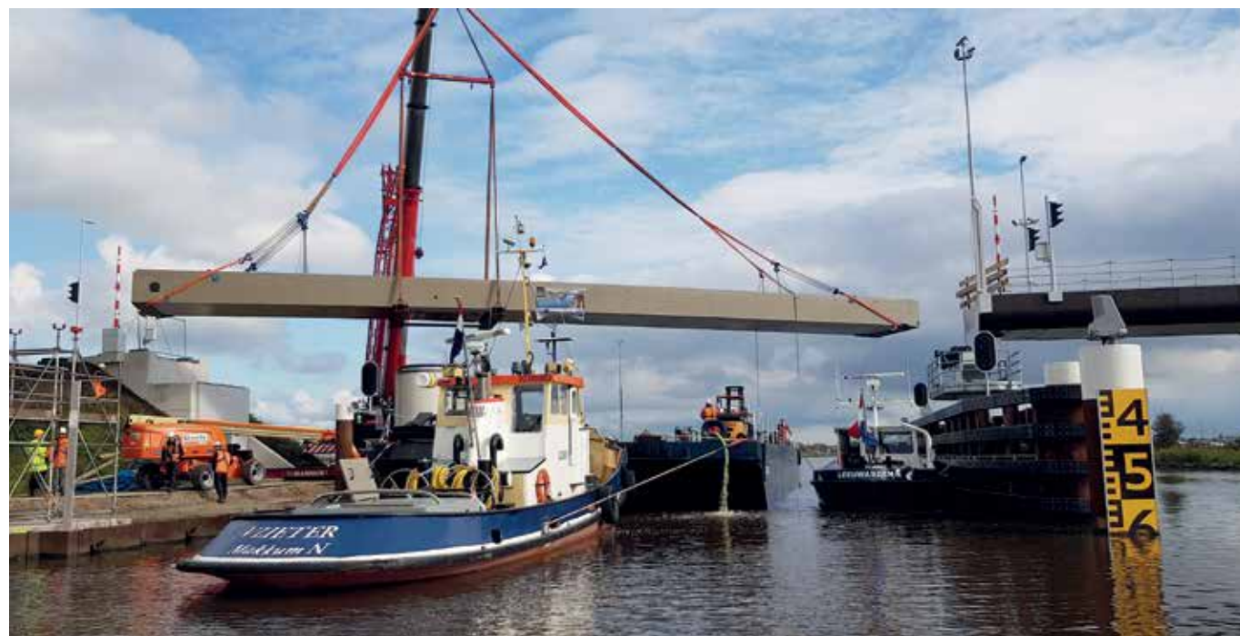
Uitvoering beweegbare biocomposiet fietsbrug over het Van Harinxmakanaal in het Friese dorpje Ritsumasy.
