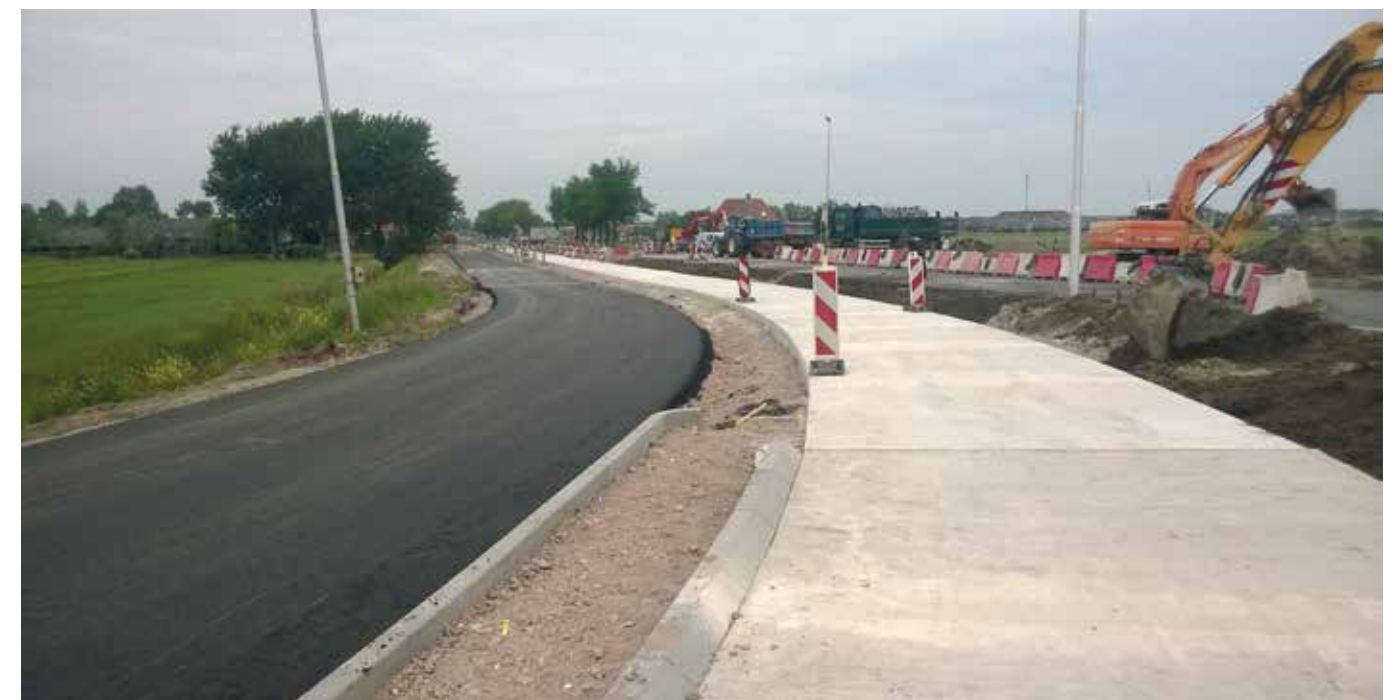
Hergebruik betongranulaat in betonnen fietspad tussen Sneek en Jutrijp (2015).
