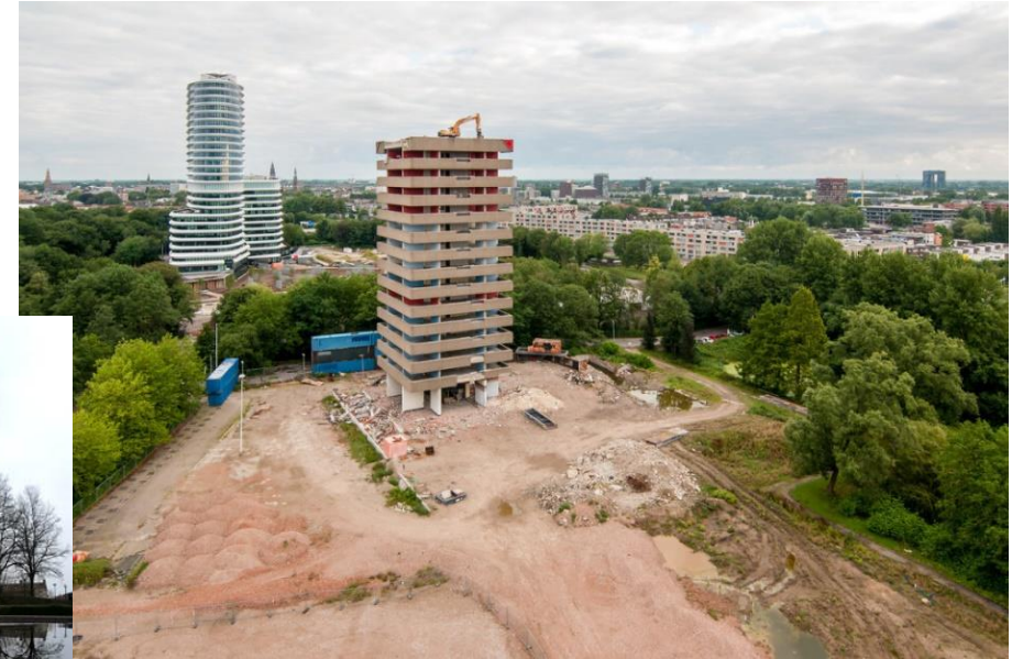
Boverhoff demonteert IBG kantoren Groningen (foto: website Boverhoff)
