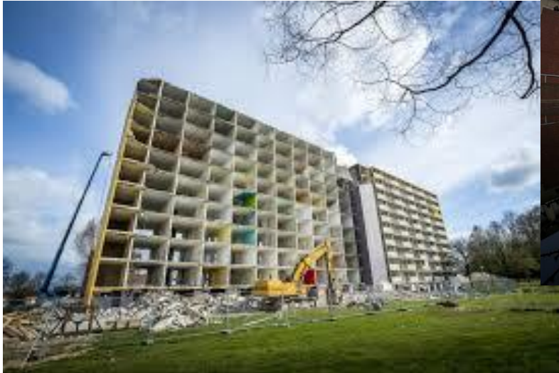
Dusseldorp demonteert appartementen in Kerkrade (foto via Google afbeeldingen)
