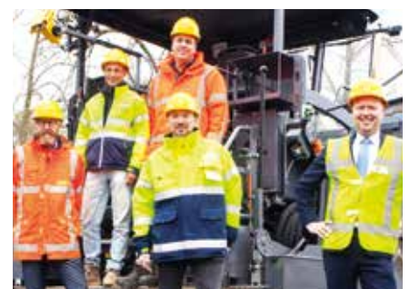
Personeel van Heijmans Infra bij de machine die een deklaag met 50 procent circulair asfalt neerlegt. Rechts wethouder Engbert Stroobos van Veenendaal.
