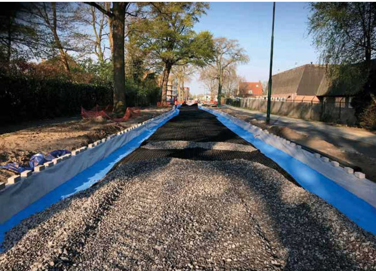
Aanleg van een weg met een lichte funderingsconstructie van Polyciviel.
