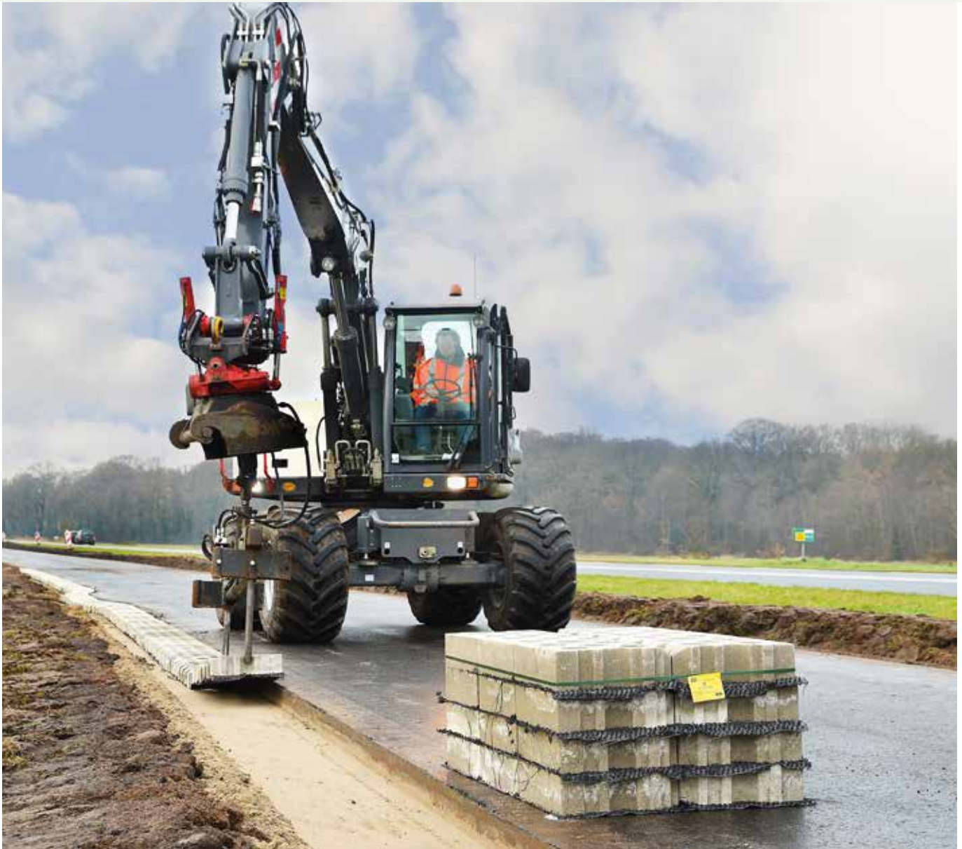
Bij het verharden van bermen laat Overijssel steeds meer als standaard grasbetontegels toepassen.
