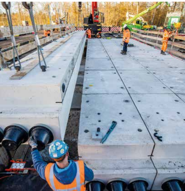
Het eerste circulaire viaduct, door Van Hattum en Blankevoort en Consolis Spanbeton opgebouwd uit betonnen legostenen.
