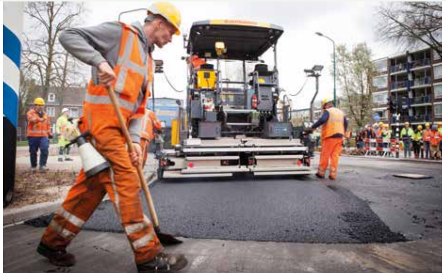
De rijbaan van de Kerkewijk in Veenendaal wordt voorzien van een deklaag duurzaam asfalt.
