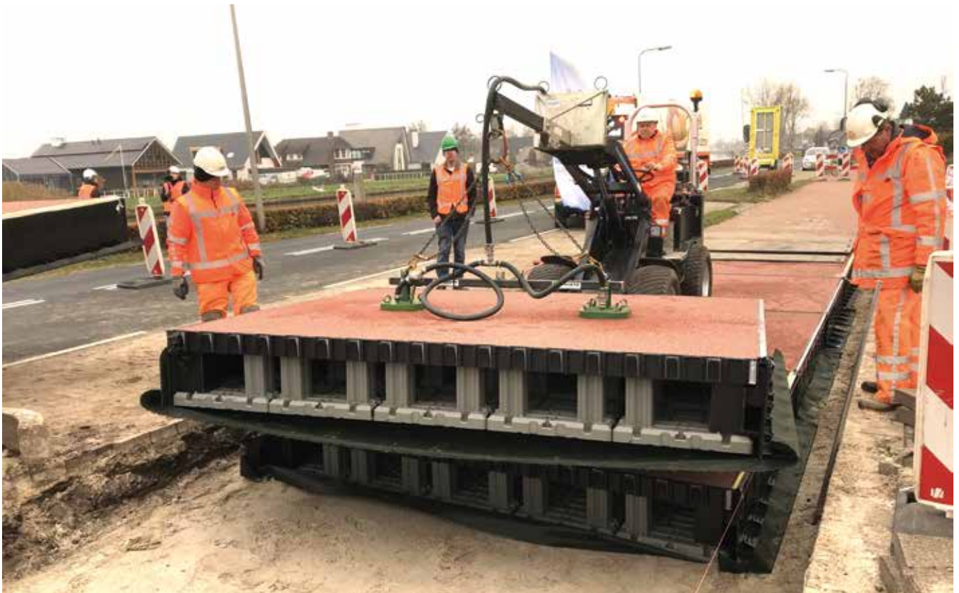
Aanleg van de plastic road in Giethoorn.
