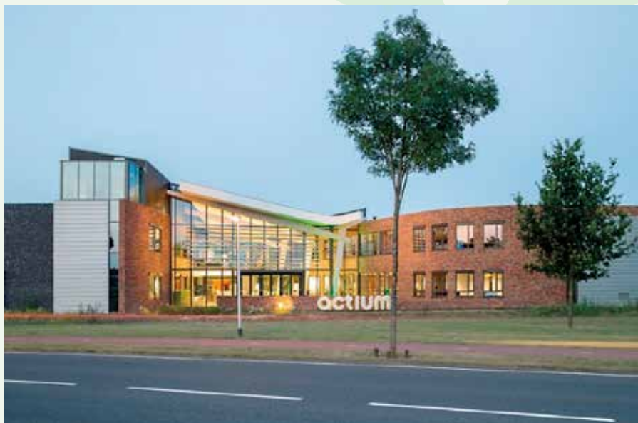
Het kantoor van woningcorporatie Actium in Assen.
