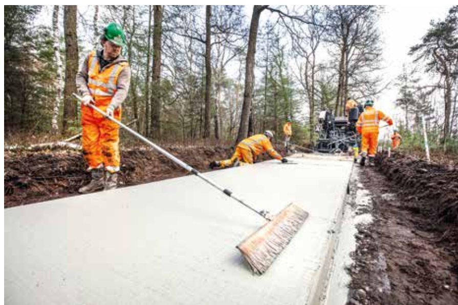
De uitvoering van het circulaire fietspad in de bossen bij Hoenderloo.
