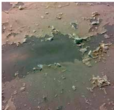
Het loskomen van de curing: het laat los en je kunt het wegvegen.
