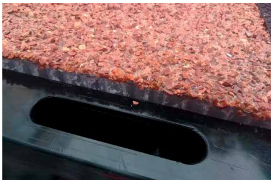
Het wegdek is voorzien van een coating van fijne steenslag om het wegdek stroever te maken. Onder het plastic bevindt zich een holle ruimte, bedoeld voor afwatering.
