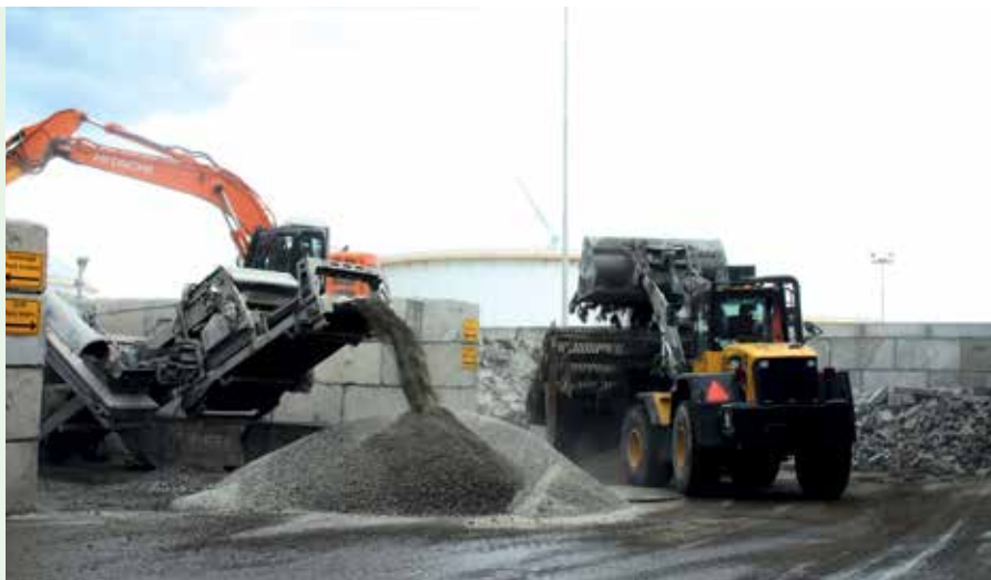
Betonpuin wordt gescheiden in onder andere 'actief cement' dat een tweede leven krijgt als freement, 'bevrijd cement'.
