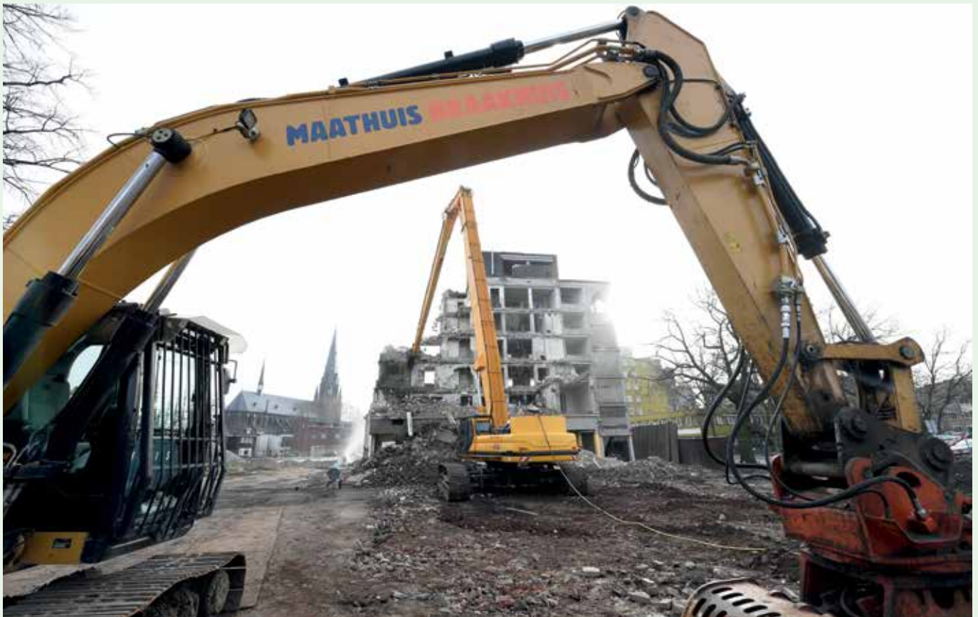
Sloopwerkzaamheden in het project Molenstraat in Enschede.
