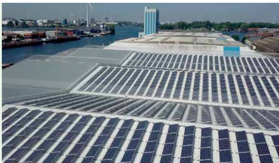
De zonnepaneelgedekte, energieneutrale productiehal van de Rutte Groep in Zaandam.
