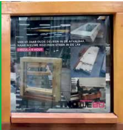
Eindresultaat circulaire kozijn. Onderdorpel hardhout, stijlen en bovendorpel zacht hout.
