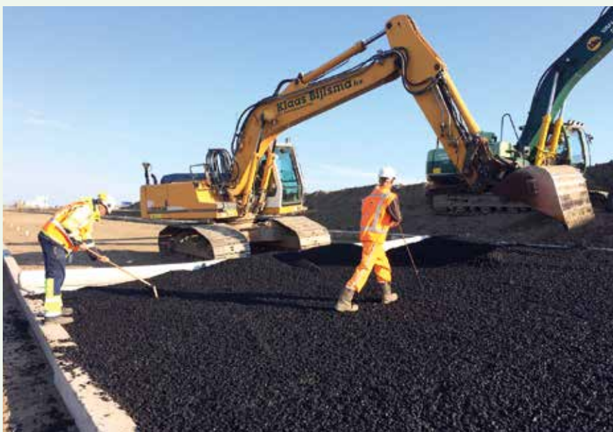
Eerder werd het nieuwe asfalt met afdruiptremmers gebruikt bij dijkversterking op Ameland.
