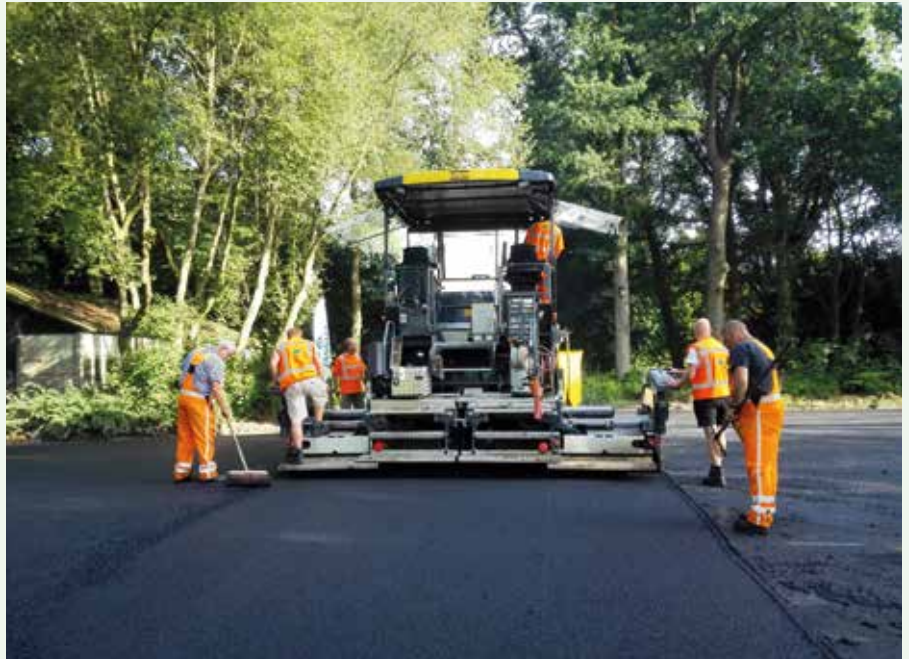
De aanleg van het fietspad bij Bedum in Groningen.
