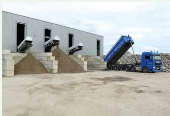
Breekinstallatie van Van Berkel Bouwstoffen & Transport in Eindhoven.
