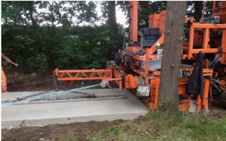
Het beton voor de N272 bestond voor ruim 80 procent uit gerecyclede materialen.
