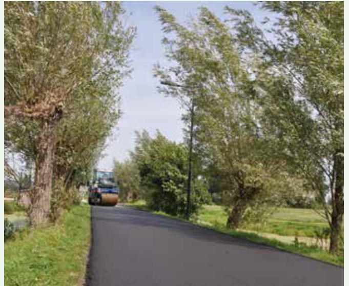
KWS legt gerecycled asfalt aan.
