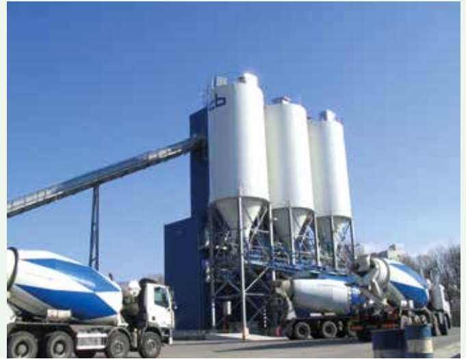
Betoncentrale Zoeterwoude van Cementbouw.
